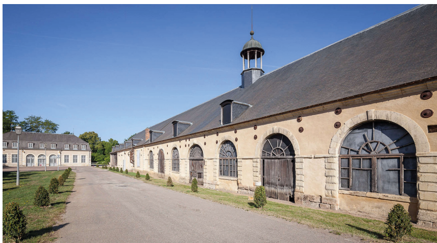
2. Guérisny, Bâtiment de « l'atelier des câbles » construit en 1823-1824 (état actuel)
