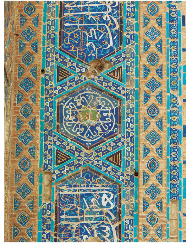
89. Shahr-i Sabz, palais Āq Sarây, détail du décor en céramique à « ligne noire » sur fond de briques non glaçurées (2013)
