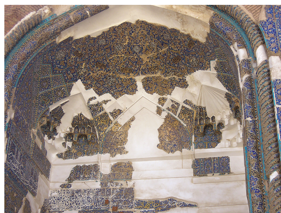
68. Tabriz, Mosquée bleue, demi-voûte du pishṭaq surplombant la porte d'entrée du monument (2014)
